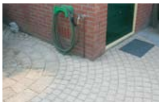
1. Locatie bepalen t.b.v. infiltratieput.
